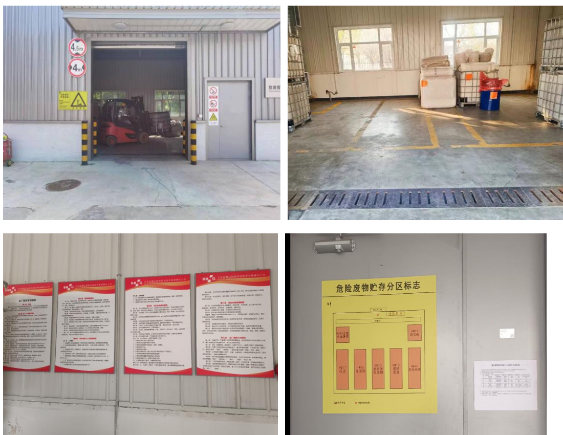
图 5.1-6 危废暂存间照片
