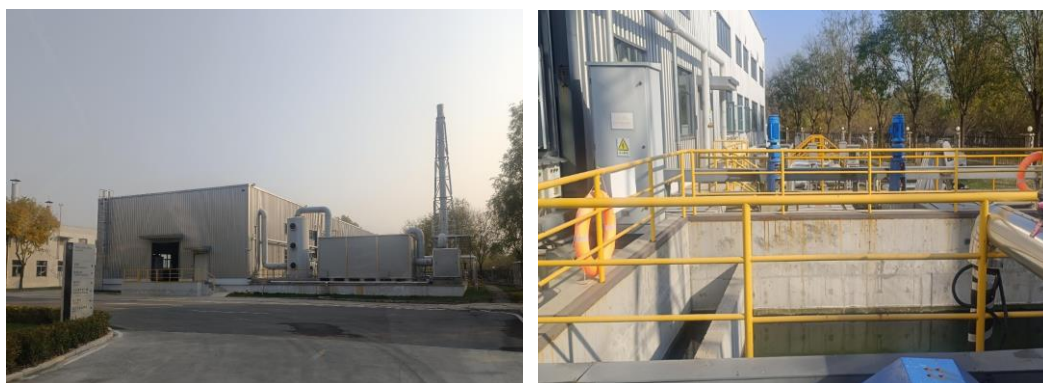
全厂综合废水处理厂
