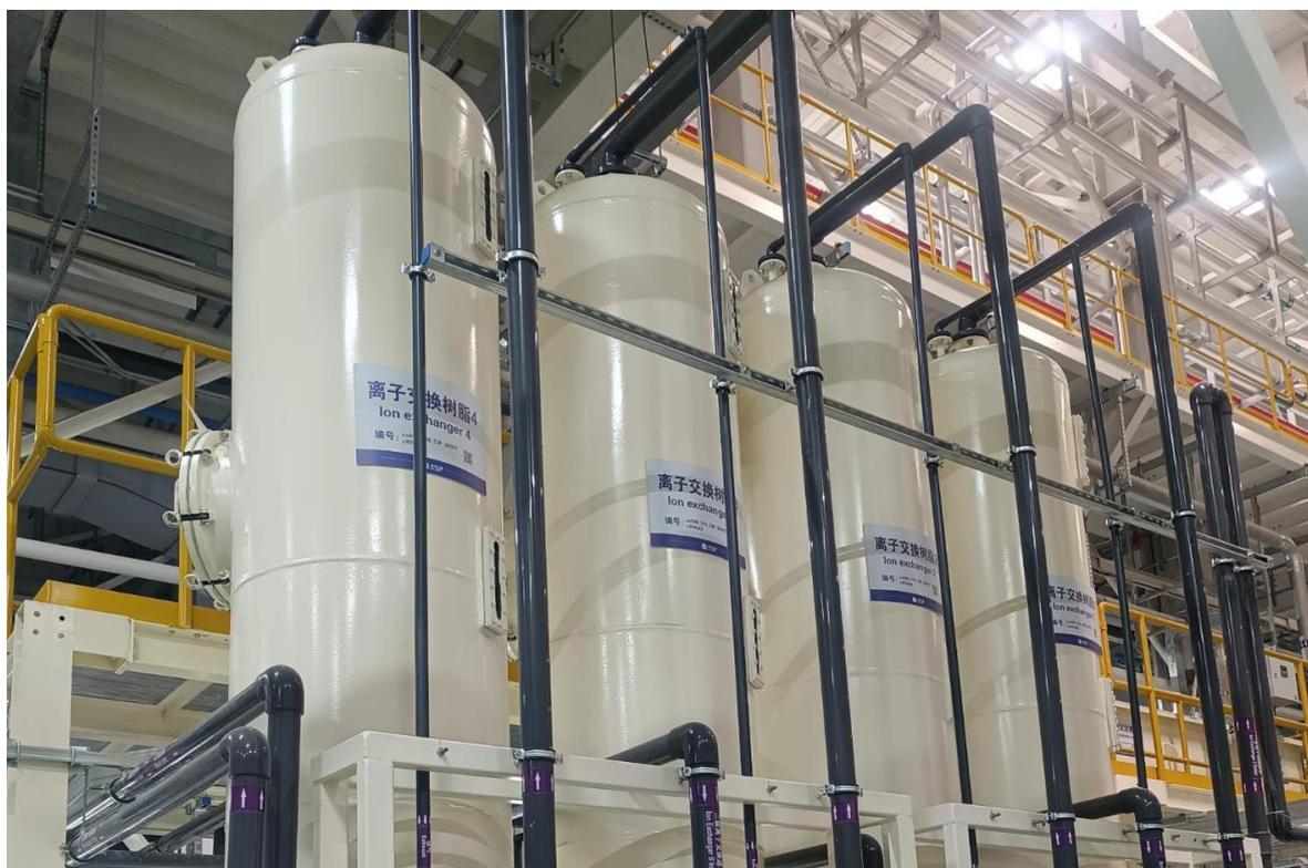
图3.9-1 磷化含镍废水预处理系统（离子交换树脂）
