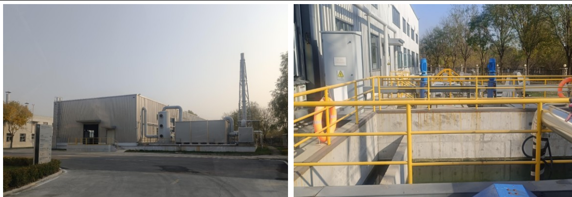
全厂综合废水处理厂
